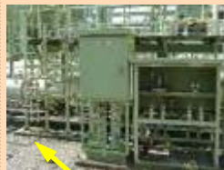
コンクリート打設
