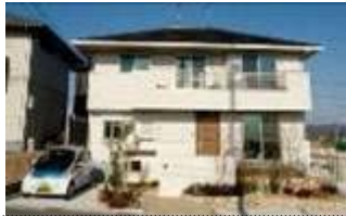
実験住宅(王寺)における実証実験
