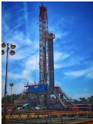
井戸掘削現場
