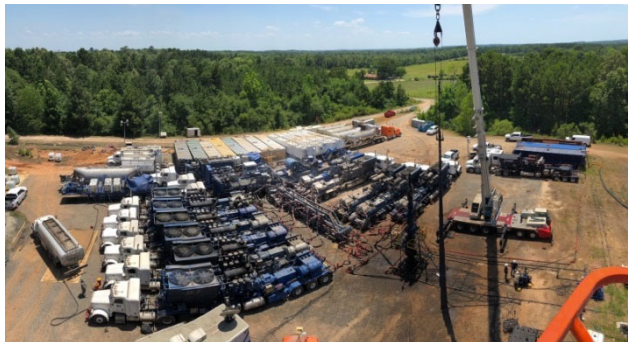
水圧破碎現場
