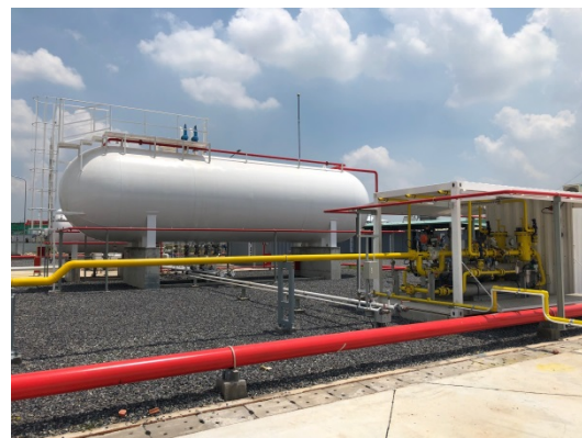
フーミー3 特別工業団地内のガス供給施設の外観
