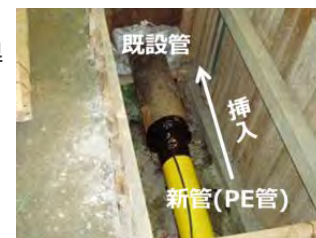
古い導管の中に、新しいPE管を入れ込むインサージョン工法
