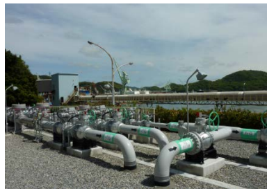
①天然ガス受入設備新設
