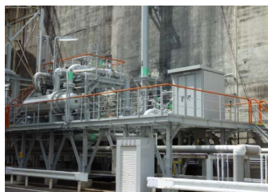
②天然ガス減圧設備新設
