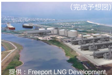
2018年度の稼働に向け液化基地を建設中のフリーポート液化プロジェクト
