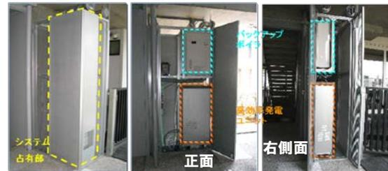
次世代型高効率SOFCプロトタイプ機の設置状況
