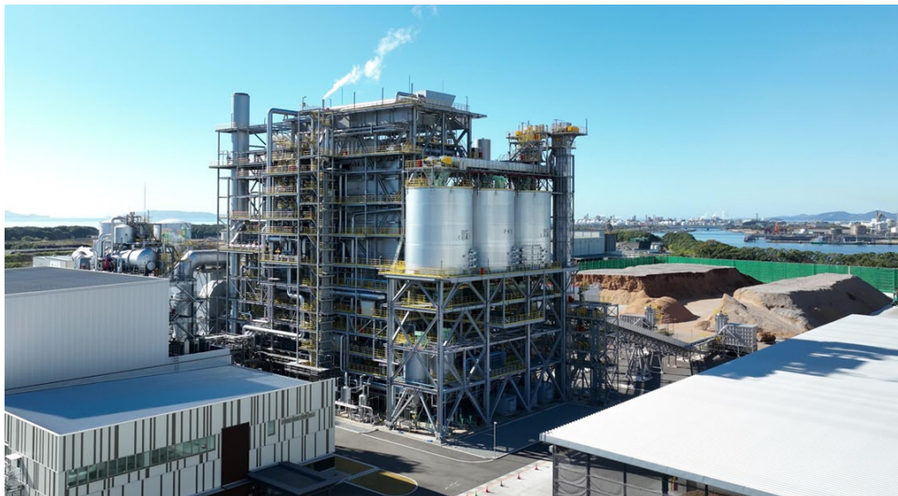
広畑バイオマス発電所／2023 年 11 月撮影
