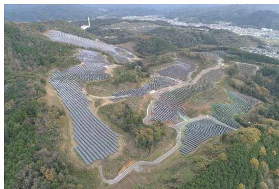
倉吉太陽光発電所（鳥取県倉吉市）
