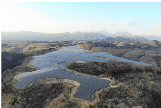
大分太陽光発電所（大分県大分市）
