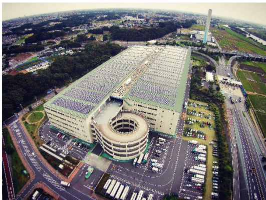
屋根置き太陽光発電所
