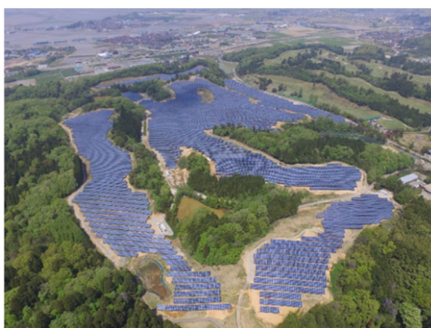
小松太陽光発電所
