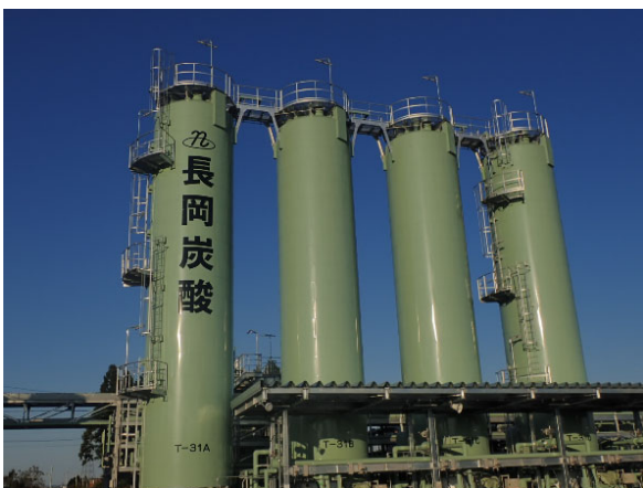
<液化炭酸ガス製造プラント>
