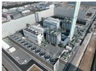
姫路天然ガス発電所（兵庫県）
