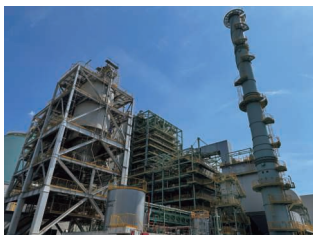
和歌山御坊バイオマス発電所（和歌山県）
