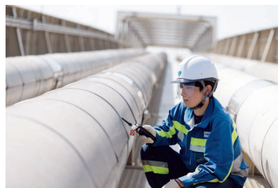
橋梁管の安全点検の様子
