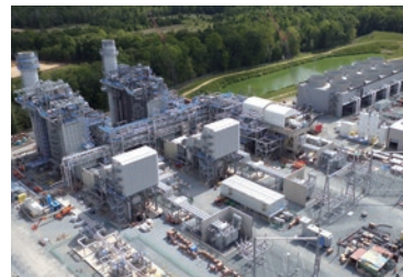
セントチャールズ 天然ガス火力発電所（建設中）
