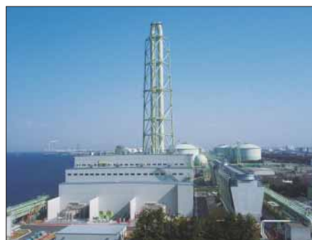
泉北天然ガス発電所(泉北製造所第二工場内)
