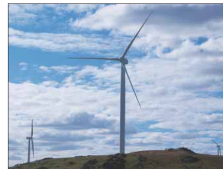
「ハレット4プロジェクト」の風力発電設備
