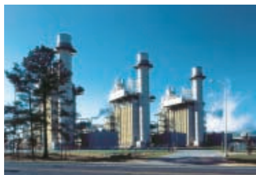
テナスカ ゲートウェイ発電所
