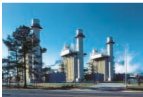
テナスカ ゲートウェイ発電所
