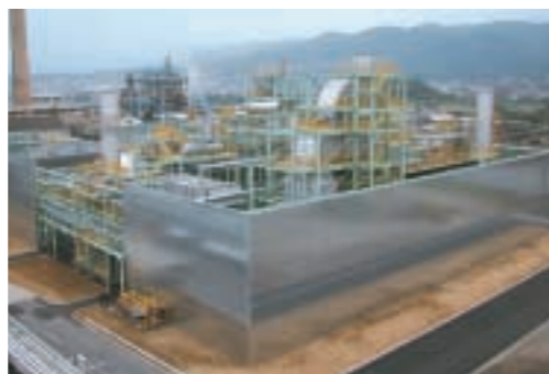
ユニチカ株式会社宇治事業所構内に建設された「電源コージェネレーションシステム」
