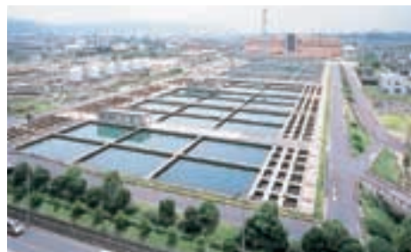
コージェネレーションの排熱が、浄水プロセスに利用されています
