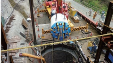
パイプライン敷設（開削）工事
