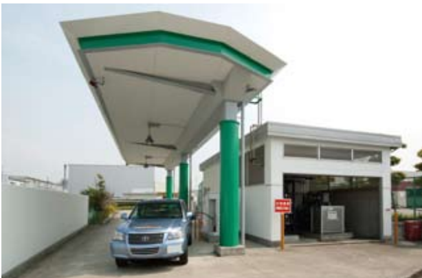
大阪水素ステーション(西島事業所構内)
