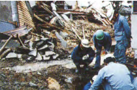
瓦礫の中での復旧作業(阪神・淡路大震災)
