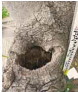
屋上キリの木の 内部の空洞
