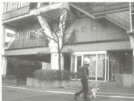
写真1 NEXT21/U-CoRoの眺め(北側街路から)
