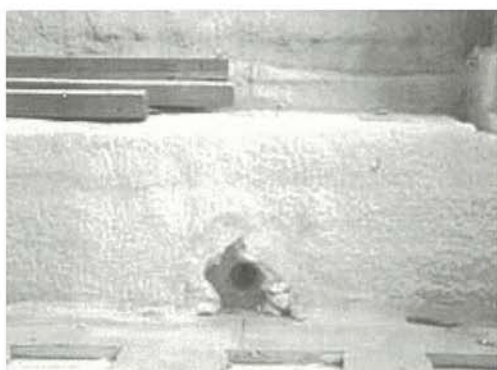
図1 足場用の梁の貫通孔(改修工事前)
