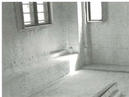
図3 足場用の梁の貫通孔の処理(改修工事後)
