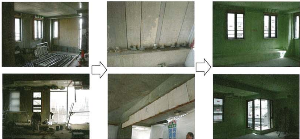
図 15 クラディング施工中写真
