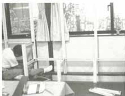
写真13：エリア2 Vフレーム組立 (3)
