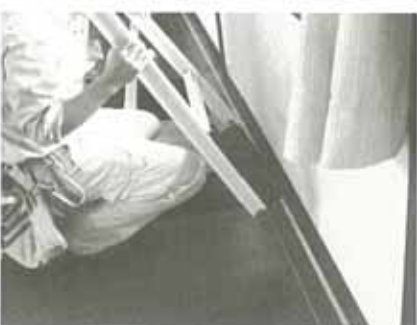
写真11：エリア2 Vフレーム組立(1)
