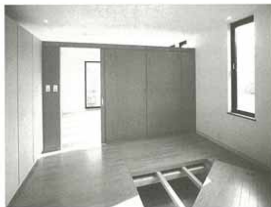
写真7：室3の大型床下収納(当初リフォーム)
