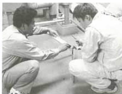
写真1：Vフレーム組立打合せ
