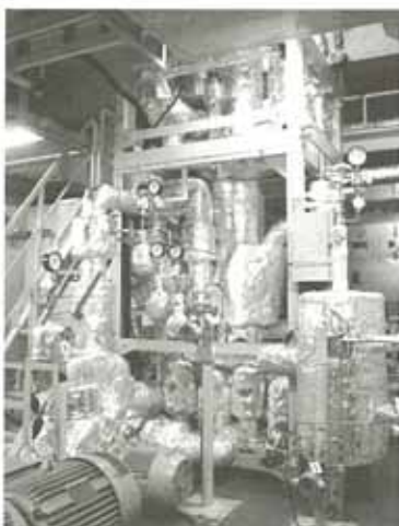
写真3：完成後のアクアーループ外観
