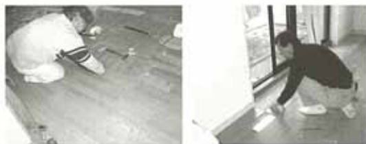
写真8：床仕上げ材の貼付け作業
