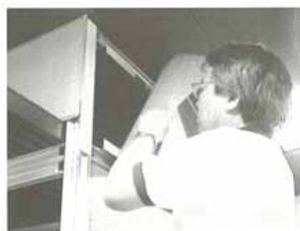
写真19：エリア1布仕上 (2)
