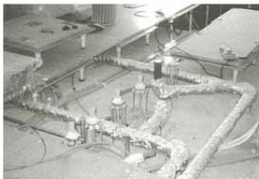
図3：床下の排水管の様子
