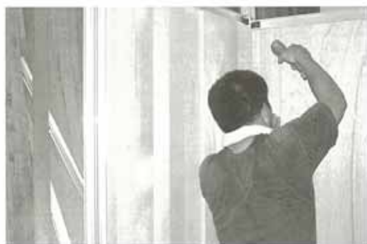
写真1：間仕切の試作
