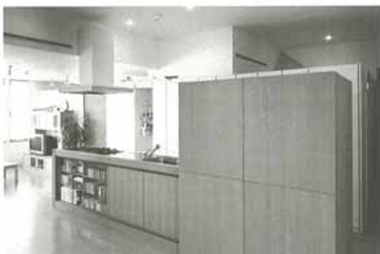
写真10：LからDを見る。キッチンの後に可変収納と可変間仕切 (当初リフォーム) ※
