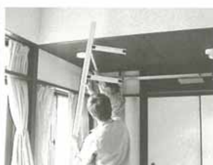
写真6：エリア1 Vフレーム組立(2)
