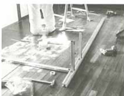
写真5：エリア1 Vフレーム組立(1)
