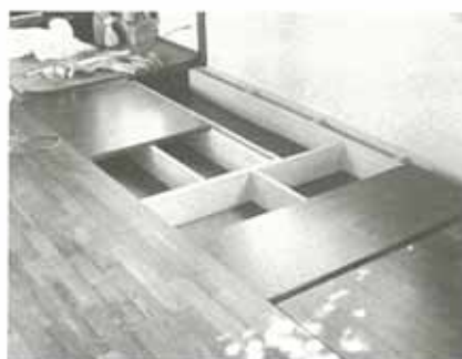
写真2：インナーテラス床段差解消
