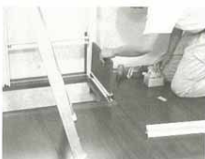
写真12：エリア2 Vフレーム組立(2)
