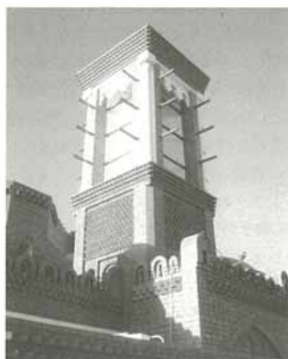
写真1：自然換気ウインドタワー
