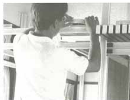
写真18：エリア1布仕上 (1)
