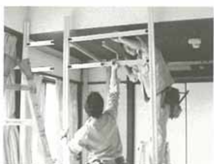
写真7：エリア1 Vフレーム組立(3)
