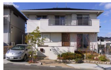
図3 居住実験住宅(奈良県王寺町)
