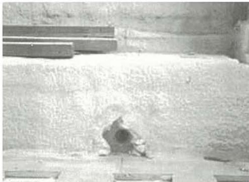
図 1 足場用の梁の貫通孔(改修工事前)
