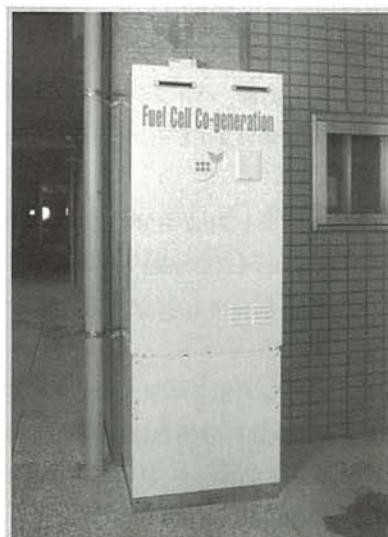
写真1 純水素駆動PEFCコーチェネレーション
