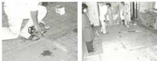
写真5：床暖房パネルの取り付け作業
