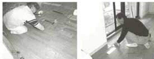
写真8：床仕上げ材の貼付け作業
