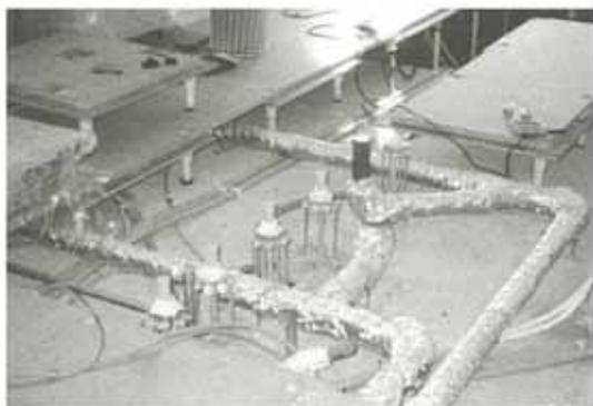
図3：床下の排水管の様子
