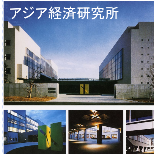
自然換気＋ハイブリッド空調 ＋パーソナル空調
