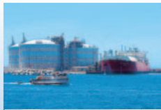
Sagunto LNG Terminal
